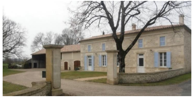
Belle rénovation de cette maison de maître dans le hameau de Coindrias
