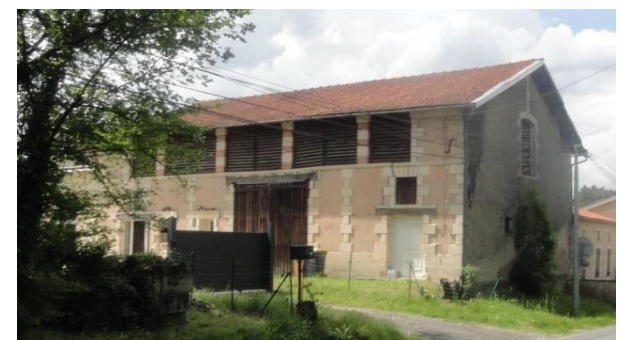
Magnifique grange (typique de la commune) à étage (ancienne étable en partie basse et foin à l'étage)
