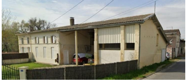
Maison rurale prolongée d'une grange ouverte (piliers en pierre)
