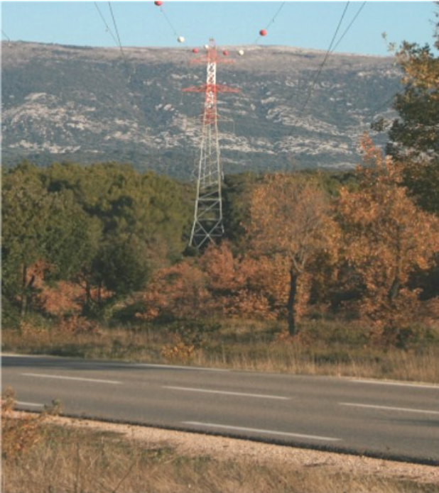
Superposition entre linéaires : route et ligne électriques
