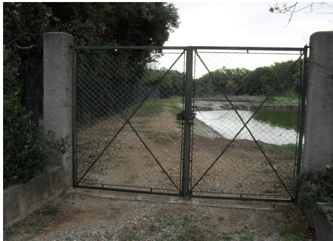
Illustration 3: Station d'épuration de Lacoste bourg
