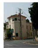
Construction à R+2
