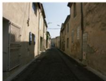
Epannelage différent entre des constructions en R+1
