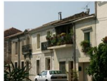
Exemple d'alignement à l'égout de toiture
