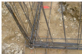
Nœud de chaînage - Continuité mécanique
