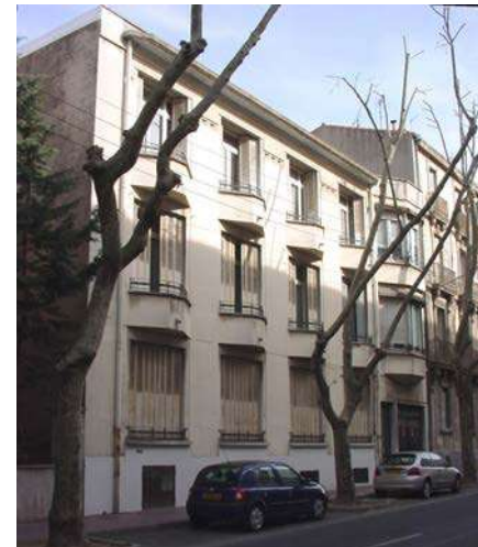
Architectes L. et R. Carlier
