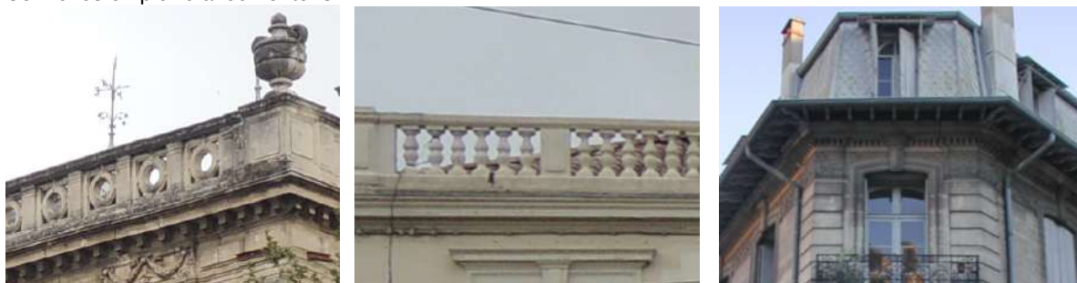
Corniches en pierre de taille avec frontons
