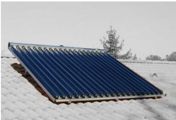
Capteurs solaires thermiques
