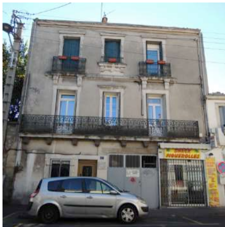
Le remplacement de la fenêtre par un modèle hétérogène nuit à l'harmonie d'origine.
