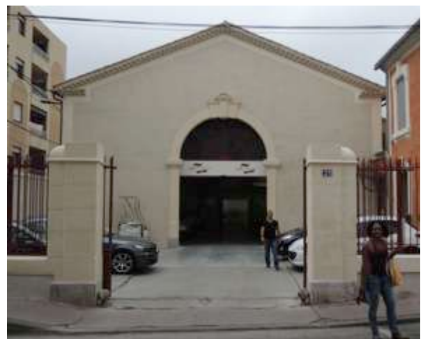
Réutilisation de hangar
