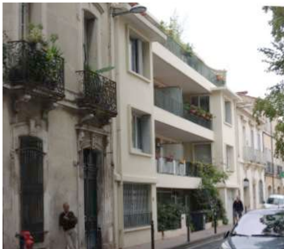
Respect du gabarit, du rythme des façades et de la petite échelle des détails.
