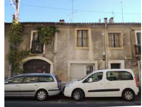
Remise agricole en RdC
