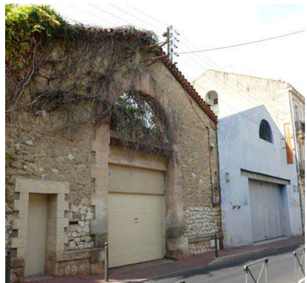
Anciens hangars reconvertis (FRAC)
