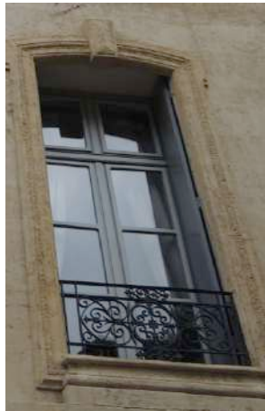
Le remplacement de la fenêtre par un modèle strictement identique à celui d'origine est quasiment imperceptible
