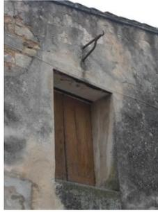
Les poulies et crochets au-dessus des ouvertures des remises agricoles, ou paillers, servaient à hisser le foin ou la paille. Lorsqu'elles étaient situées en étage, ces pièces assuraient une bonne isolation thermique au niveau du logis qui pouvait se trouver en dessous.
