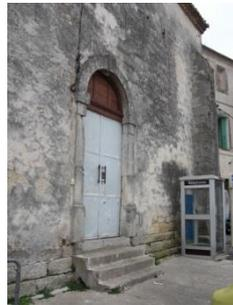
Porte en bois remplacée par un élément en métal inesthétique et inadaptée: l'imposte d'origine demeure, ce qui crée une confusion des genres.
