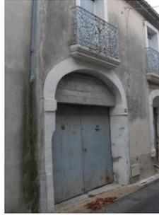
Ancien linteau en pierres remplacé et consolidé à tort par du béton. Ce dernier altère la souplesse naturelle d'un mur en pierres sur le sol, ce qui risque d'entraîner des fissures.
