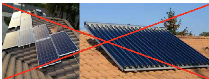
Implantations interdites : implantations anarchiques et/ou en sur-épaisseur trop importante
