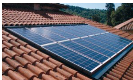
Implantations autorisée : intégrée à la toiture
