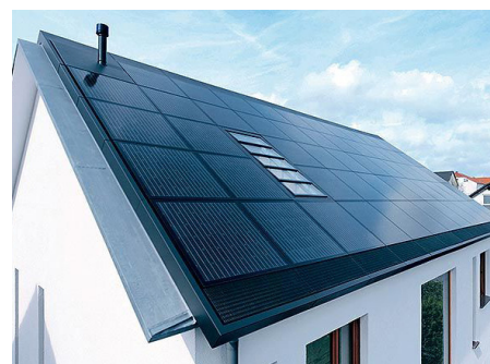
Exemple de couverture photovoltaïque.
