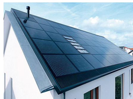
Exemple de couverture photovoltaïque.
