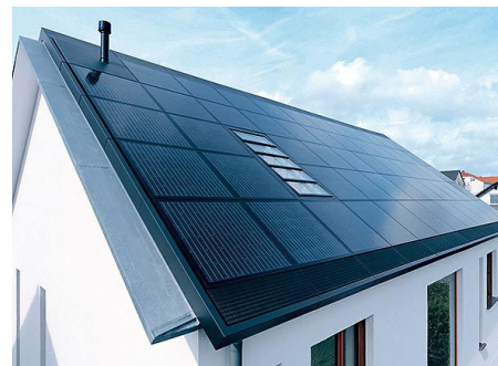
Exemple de couverture photovoltaïque
