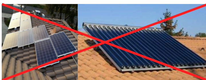
Implantations interdites : implantations anarchiques et/ou en sur-épaisseur
