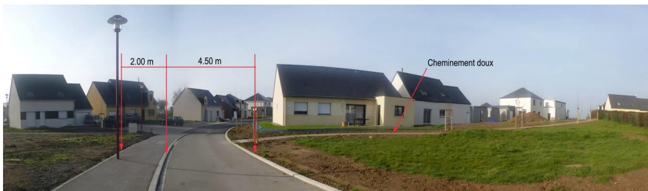
Maisons pavillonnaires (rue du Coteau)
