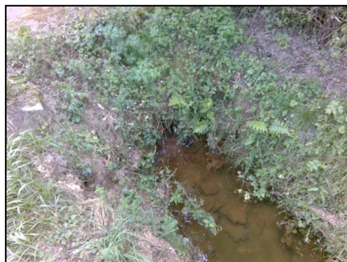
Exutoire du bassin versant n°1
