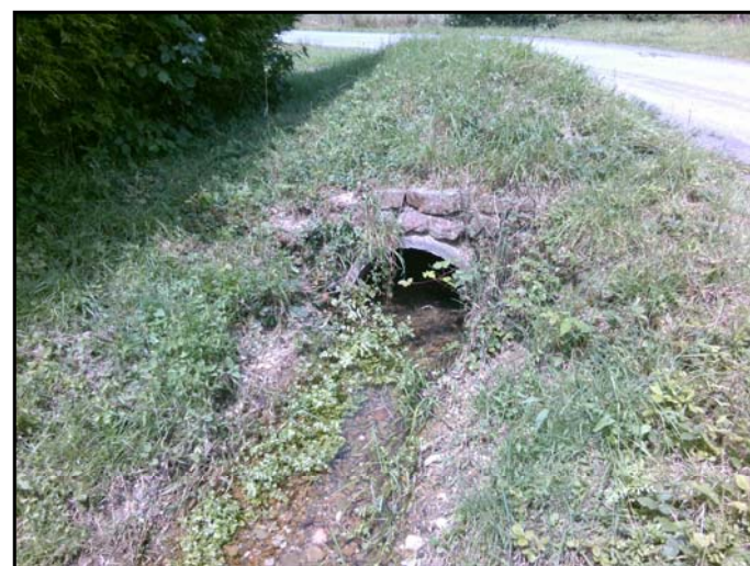
Exutoire du bassin versant n°7
