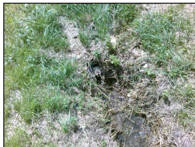
Exutoire du bassin versant n°3
