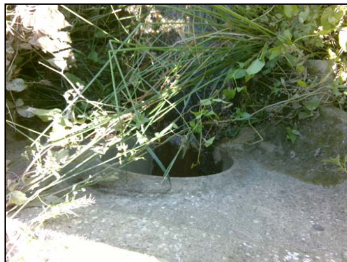
Exutoire du bassin versant n°5
