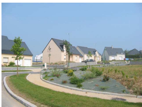
Aménagements paysagers du lotissement "Les Rochers"
