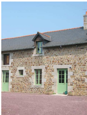
Maison - rue du Maine
