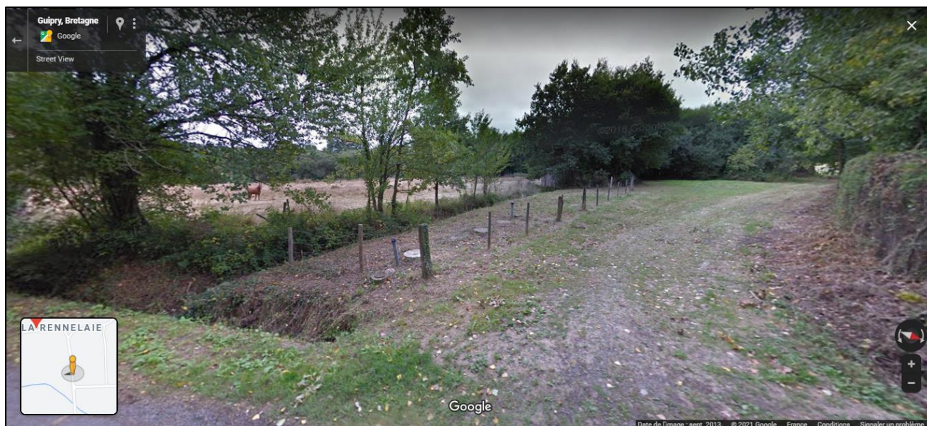
Figure 29 - Photographie Streetview de la station d'épuration de la Rennelaie (Google, septembre 2013)
