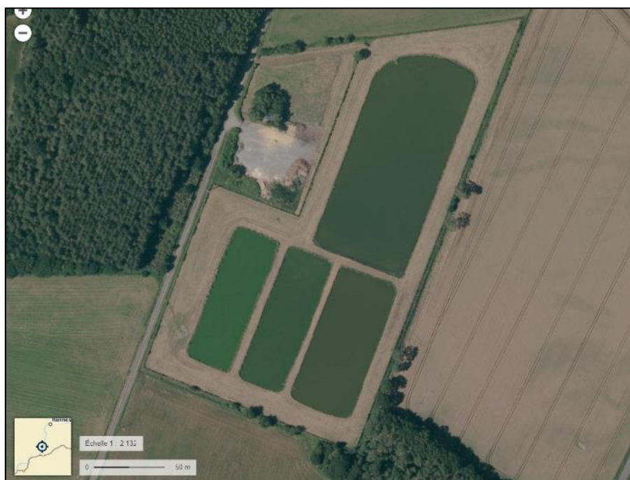
Figure 31 - Vue aérienne de la station de Corméré (Messac)
