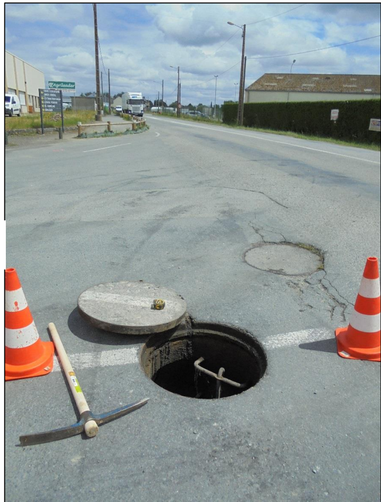
Photo 1 : Vue d'un regard de visite eaux pluviales ouvert durant la phase terrain
