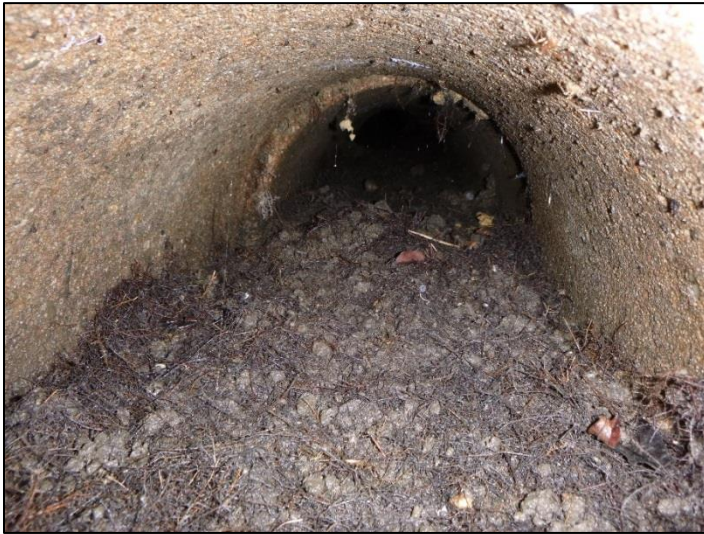
Photo 2 : Vue d'un réseau à curer – Réseau Ø300 de la route de la Chambre
