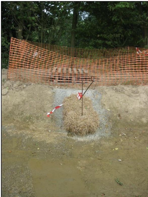
Photo 14 : Emplacement du filtre à particules fines (botte de paille) pendant la phase des travaux au niveau du bassin d'orage
