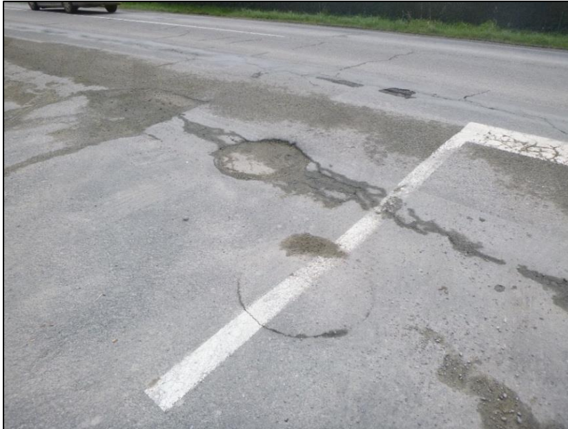
Photo 4 : Vue d'un tampon non accessible de la ZA la Janaie
