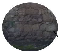
Murs en pierre
