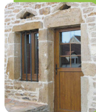
Encadrement avec arc de décharge
