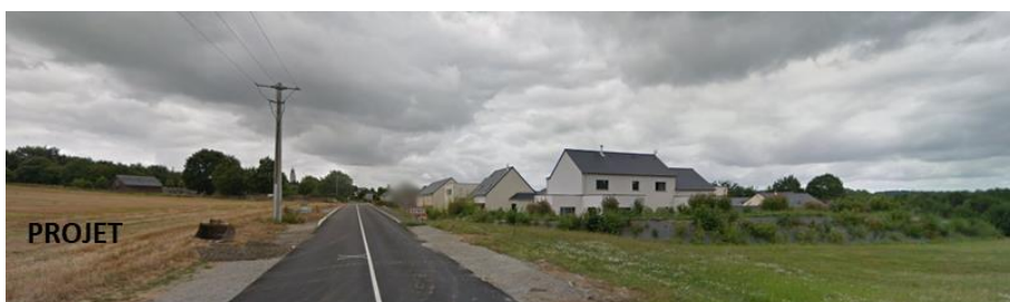
Entrée d'agglomération Est, route départementale n°34
