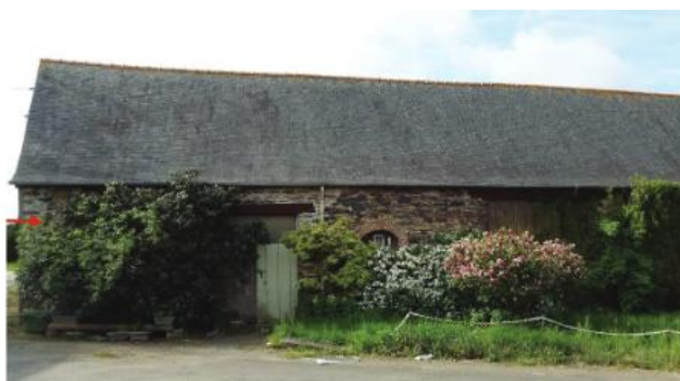
Exemple de bâtiments désignés
