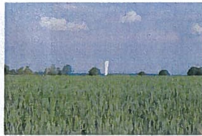
le château d'eau est un repère à plusieurs kilomètres à la ronde
