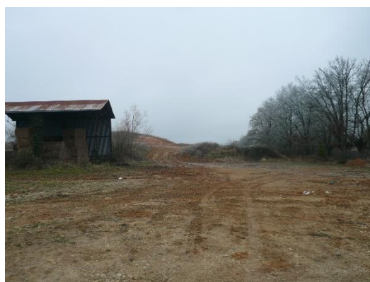
Stockage des matériaux naturels issus des creusements des casiers B
