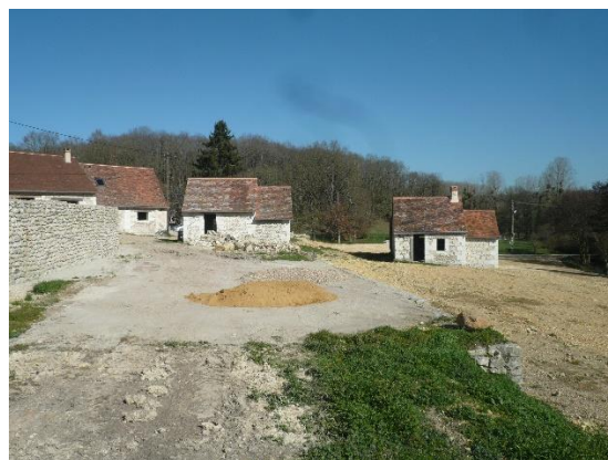
Bâti ancien du hameau concerné par le projet. Après démolition d'un hangar, le site a été nettoyé
