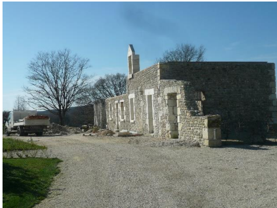
Réhabilitation en cours du troisième hébergement
