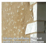
Calcaire dur en chaîne d'angle et enduit à pierres vives à Chempagne
