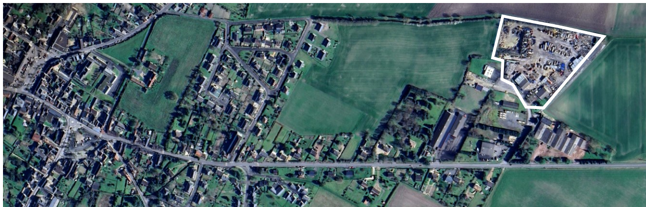
Figure 20 : vue du site d'activité de Vernat TP de la Chapellerie à Ligueil
