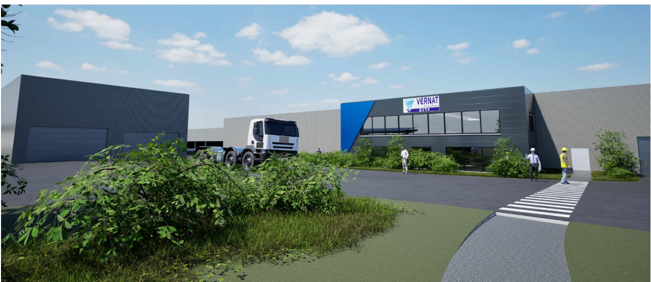
Figure 29 : vue rapprochée des bureaux et des ateliers de maintenance
