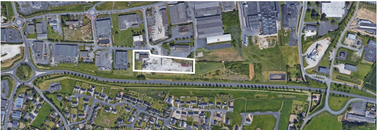
Figure 24 : vue des bureaux, du dépôt et de la centrale à béton de Vernat TP au sein de la zone d'activité de Vauzelle
