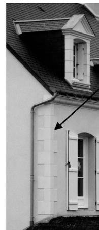
Chaînage d'angle en enduit maçonné
