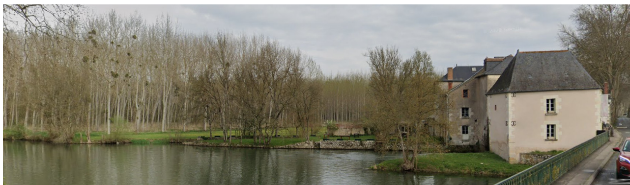
Photo 18. Moulin Lambert marquant l'entrée de Pont-de-Ruan
