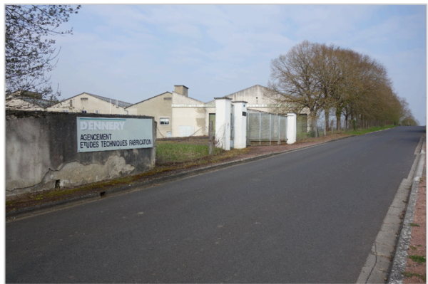
Vue 3 – Accès au site
