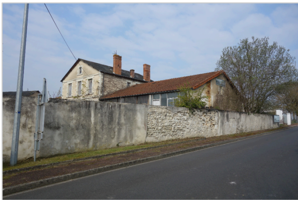
Vue 2 – Route du Grand Pressigny
