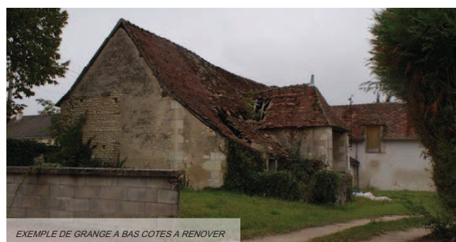
EXEMPLE DE GRANGE A BAS COTES A RENOVER
