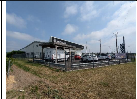
Vue sur le garage
