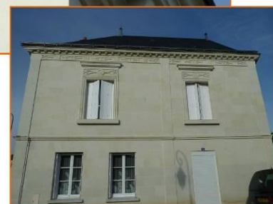
Maison du lavoir rue du Pont Mineau
