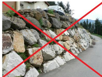
Exemple d'enrochements de type cyclopéen
