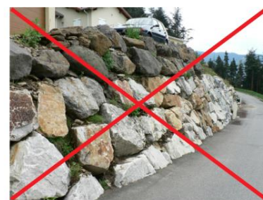
Exemple d'enrochements de type cyclopéen
