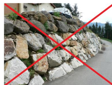
Exemple d'enrochements de type cyclopéen
