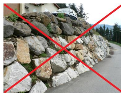
Exemple d'enrochements de type cyclopéen
