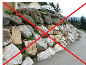
Exemple d'enrochements de type cyclopéen
