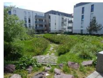
Valorisation & préservation de zones humides par la réalisation d'un jardin de pluie – ZAC Rives de Blossne - Cerema
