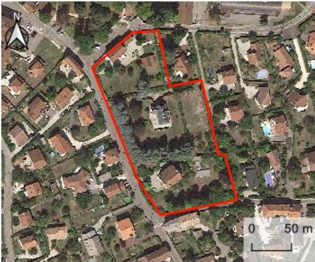
Photo aérienne du site de l'OAP 1-B
