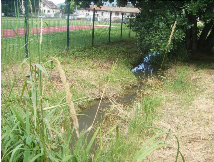
Fossé en eau au sud en limite de site
