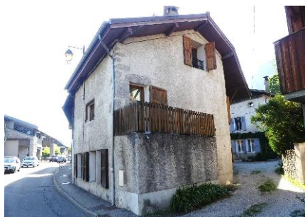
Entrée d'une cour commune sur la RD 1090
