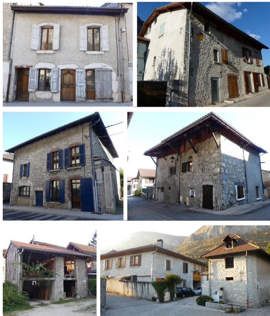
Exemples de constructions identifiées comme patrimoine bâti d'intérêt. Il s'agit notamment des constructions témoignant du patrimoine urbain et rural de Crolles : maisons de bourg, maisons rurales, anciennes fermes, dépendances intéressantes, etc.
