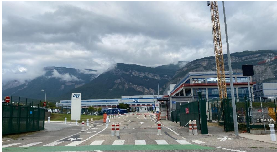
Entreprise SMicroelectronics dans le parc technologique /Citadia Conseil
