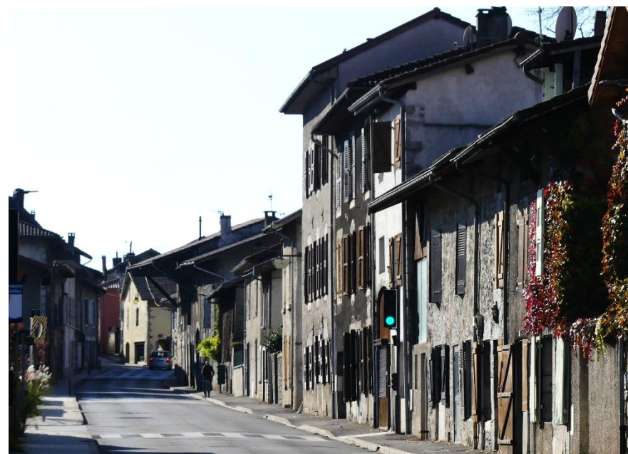
Alignements de façades sur la RD 1090
