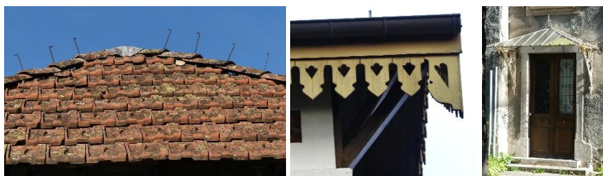
Tuiles « mécaniques », lambrequins, marquise
