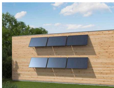
Dispositif plaqué sans lien avec les éléments constructifs
