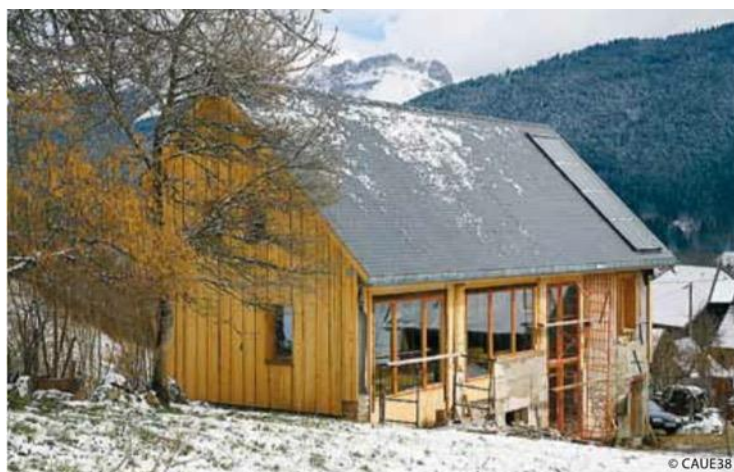
Rénovation d'une grange en habitation «passive» grâce à une isolation renforcée en paille. La toiture intègre une nappe de panneaux solaires photovoltaïques. Item Architectes.
