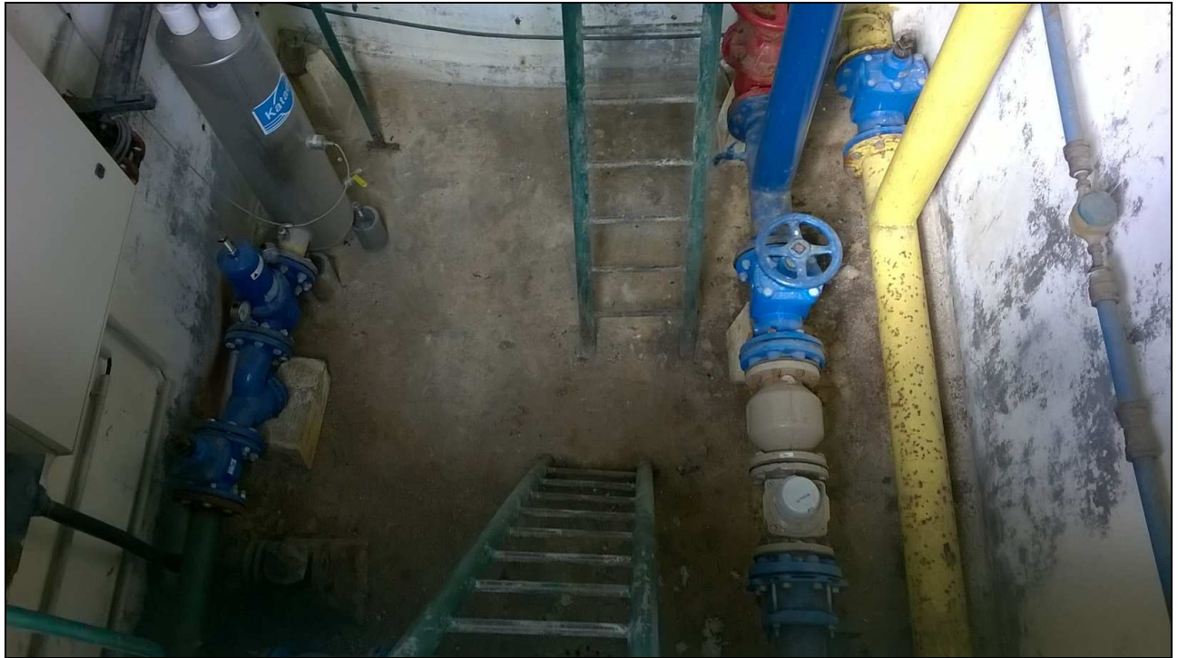
Vue intérieure du réservoir
