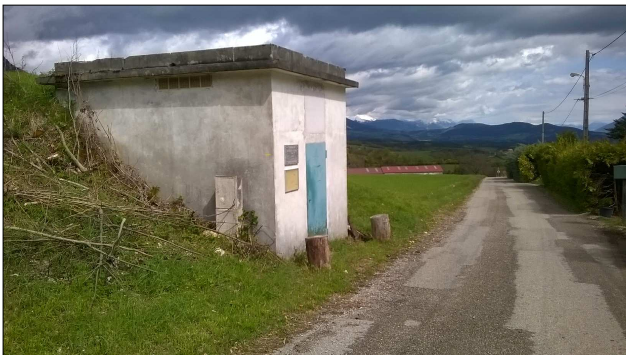
Vue extérieure du réservoir
