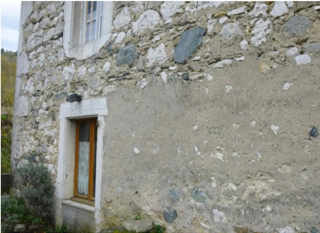
Une mise en oeuvre traditionnelle d'un enduit à la chaux, qui recouvrait les pierres, en partie basse. Il est usé en partie haute.
