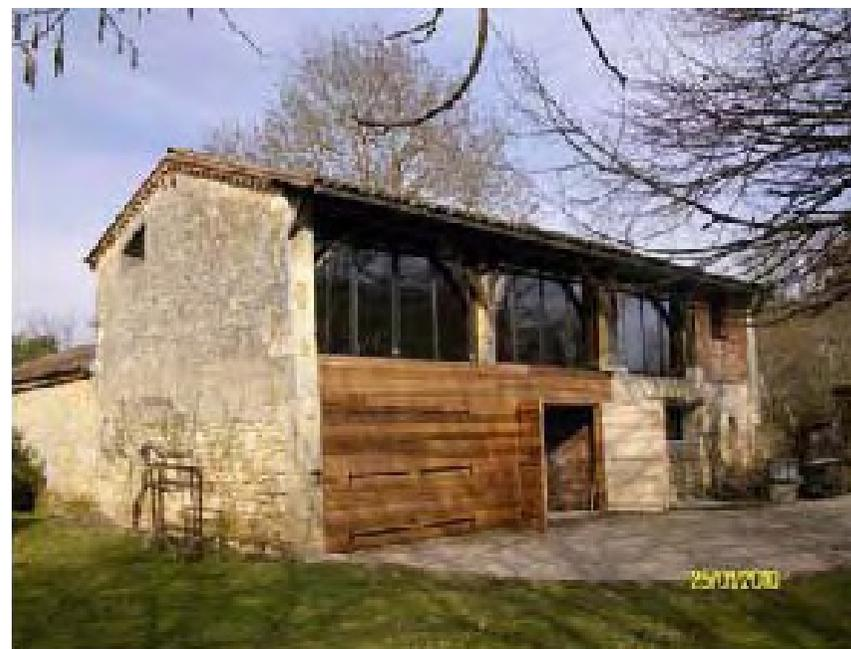
*Le projet respecte la dimension des ouvertures originelles et laisse la structure apparente de manière à rendre bien lisible son ancienne fonction de grange. Les matériaux utilisés sont le bois laissé naturel et le métal pour les baies vitrées.*
