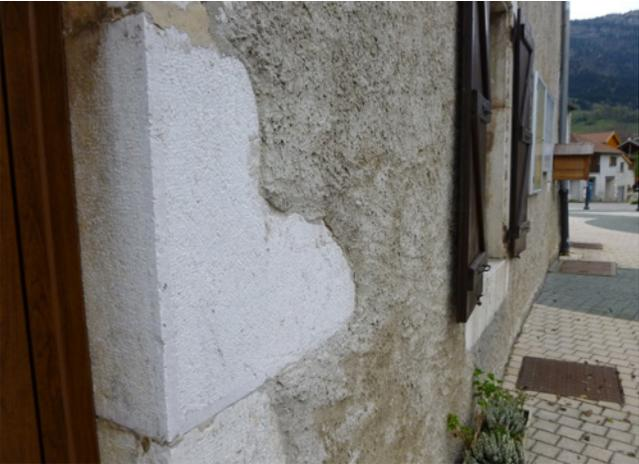
Un enduit ciment grossier et posé en surépaisseur. Les enduits ciments empêchent l'humidité de sortir des murs et dégradent les joints puis les pierres, et ainsi le bâtiment à terme.
