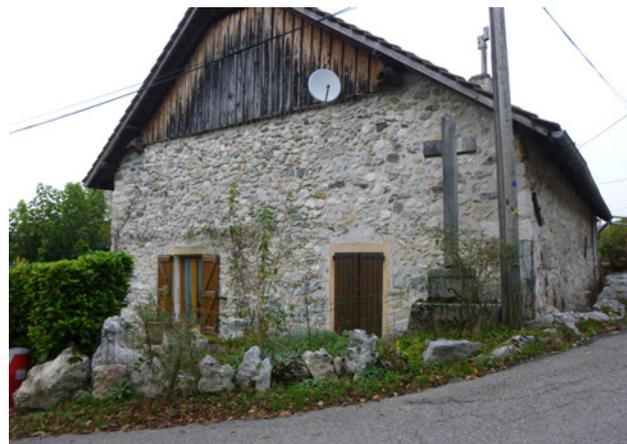
Le bois est réservé aux granges, mais n'est pas utilisé de manière systématique. Il est peu utilisé et rempli les vides situés en partie haute des murs maçonnés, afin de permettre la ventilation de la grange à foin. Les bardages sont en bois laissé naturel et sont toujours verticaux.
