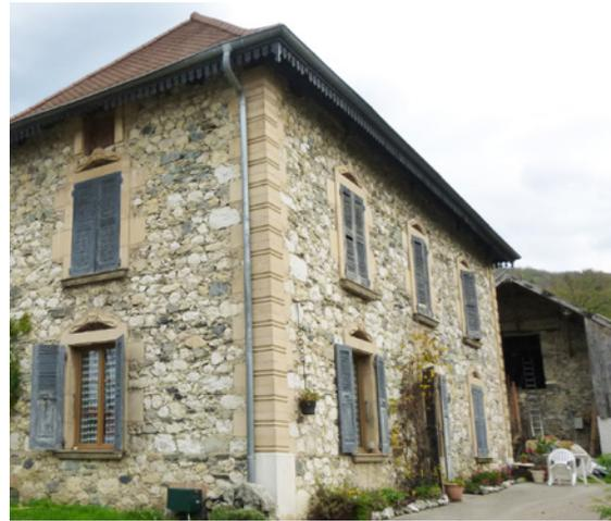
La toiture est à quatre pans et présente une forme travaillée avec un coyau (pente plus douce en bas de toiture, permettant notamment une meilleure évacuation des eaux de pluie). Un lambrequin souligne la rive de la toiture.
