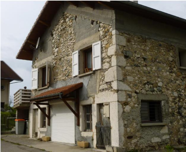
Une modification des ouvertures sans cohérence, un petit auvent / entrée de garage et un volet roulant qui dégradent le bâtiment.
