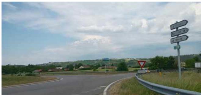
Vue depuis le Sud
