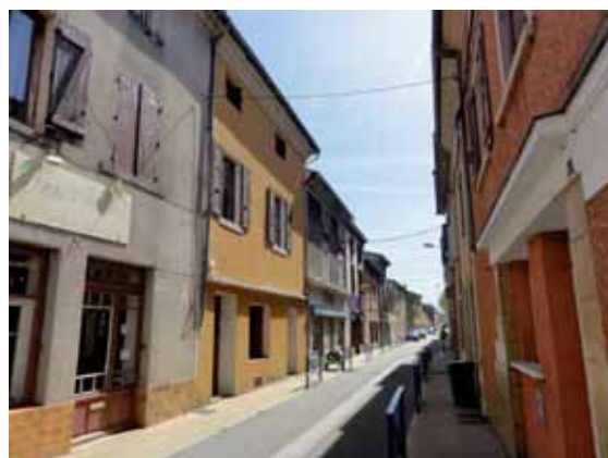
Maisons de ville dans le centre ancien
