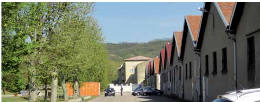
Façade Nord des bâtiments rue de Champagnole
