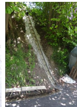
Collecte des eaux de voiries en surface, plus ou moins bien dimensionnées
