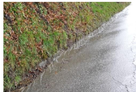
Collecte des eaux de voiries en surface, plus ou moins bien dimensionnées
