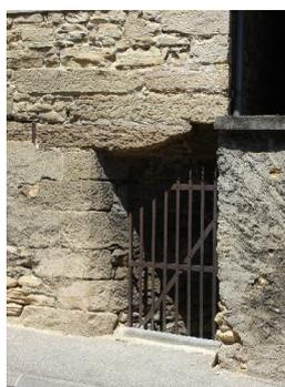
Portail d'accès inséré entre un mur de clôture et une chaîne d'angle rabattue
