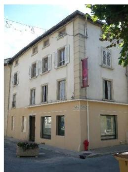
Le chaînage d'angle est invisible au rez-de-chaussée qui a pourtant conservé l'arceau métallique protégeant le mur des roues des véhicules.
