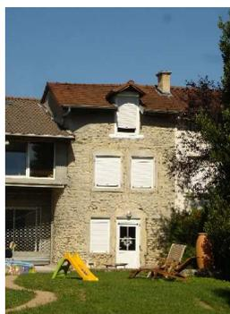
Vestige de mur courbe à gauche de la maison de la parcelle AH 60. Un coup de sabre est bien visible dans la hauteur de l'étage, entre les deux maçonneries.
