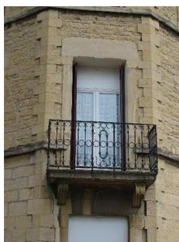
Balconnet soutenu par deux consoles cannelées à volute supérieure sortante, garde-corps de fer forgé.
