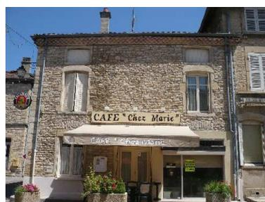
Façade sur la place : attique clos, arcs de décharge au rez-de-chaussée, feuillures aux encadrements des fenêtres.
