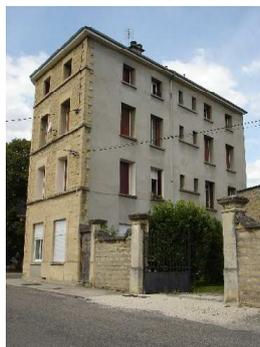
Façade arrière avec les baies de la cage d'escalier bien repérables, le portail (piliers en pierre de taille moulurés) et le mur de clôture de la cour.
