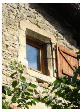
Fenêtre carrée à encadrement chanfreiné s'amortissant en congé sur les piédroits au niveau du comble
