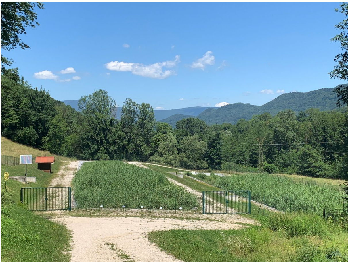
Photo de la station d'épuration (photo CDHU)
