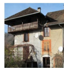
Four à pain, le village Saint-Bueil construction spécifique
