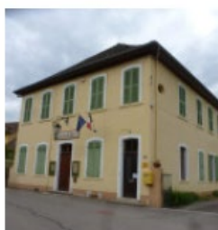
Mairie Saint-Bueil bâtiment administratif XIX e
