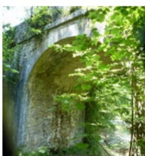
Pont de l'Aigueblanche Saint-Bueil route et voie ferrée
