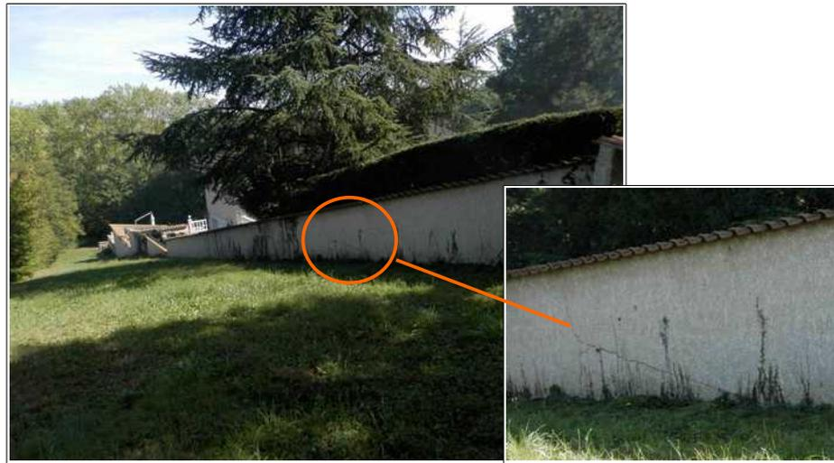
Aval de la route communale de L'ÉGLISE, des murs de clôture sont fissurés. Le glissement de terrain s'est produit à l'amont de la route. En médaillon, gros plan sur la zone fissurée. On notera la pente du terrain.
