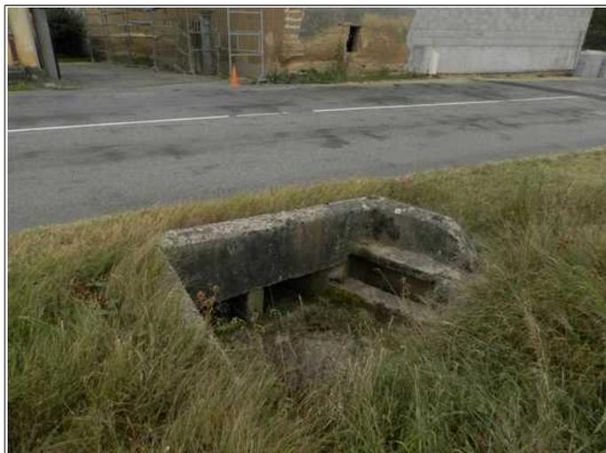
Combe du PLAN, gros plan sur l'ouvrage de franchissement de la RD36. On notera sa faible section et la géométrie de son ouverture qui est favorable à la formation d'embâcles.
