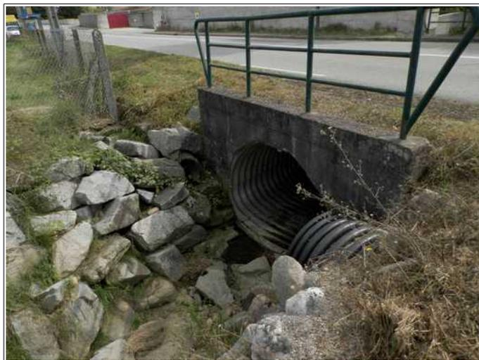
Franchissement de la RD36, on notera la canalisation d'eaux pluviales sur la droite de la photo.
