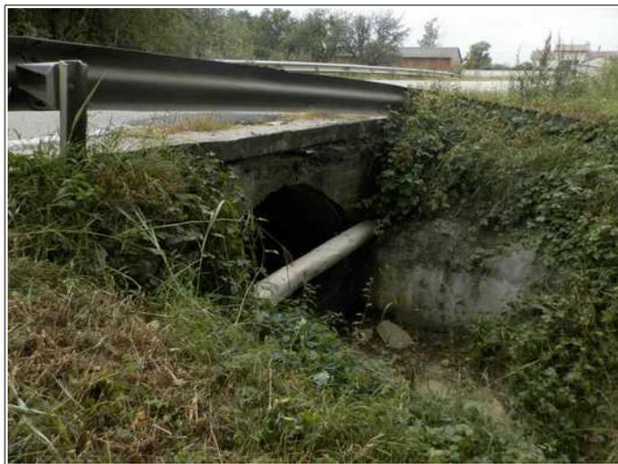
Franchissement de la RD36 par le ruisseau du CANIS, on notera la faible ouverture de l'ouvrage et la canalisation réduisant sa capacité. C'est également à ce niveau qu'a lieu la confluence avec la COMBE DES BOUTIÈRES.
