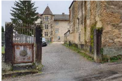
Rue de l'église, ancienne entrée
