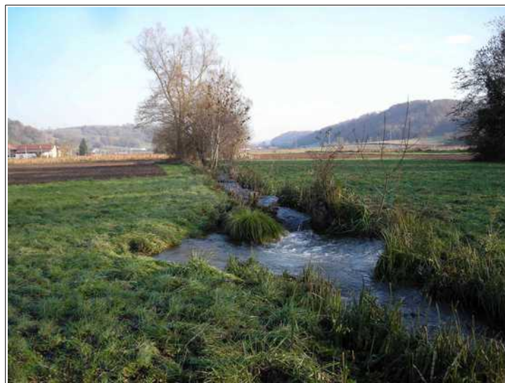
Vue du ruisseau à l'amont du bourg, on notera l'étroitesse du lit mineur et la planéité de la vallée générant un champ d'inondation relativement large.
