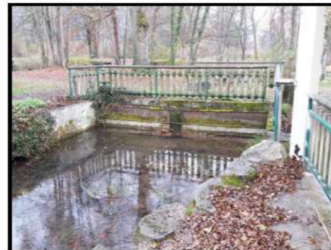
OH-11 - vue de l'amont
