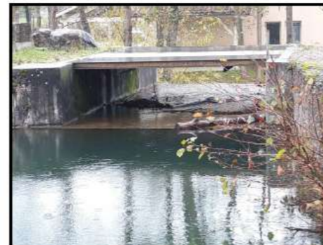
OH-05 - vue de l'amont
