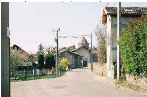
En arrivant par la route de Chapèze et de Prémis, le donjon du château domine les habitations
