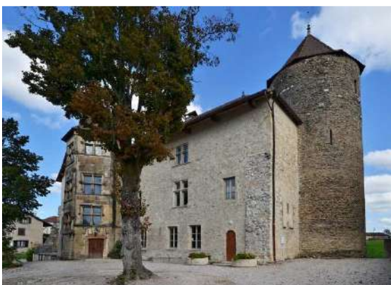
Vue de la partie avant du château depuis la cour (de gauche à droite : tour hexagonale, logis, donjon)
