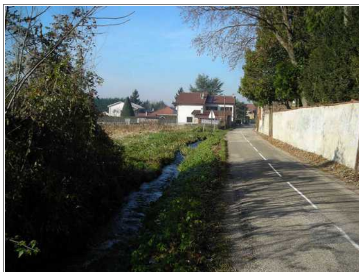
Canal d'arrosage déviant une partie de l'eau du ruisseau de SAINT-SAVIN en direction de LA GRANDE CHARRIÈRE.
