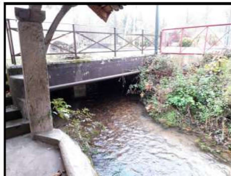
OH-04 - vue de l'aval
