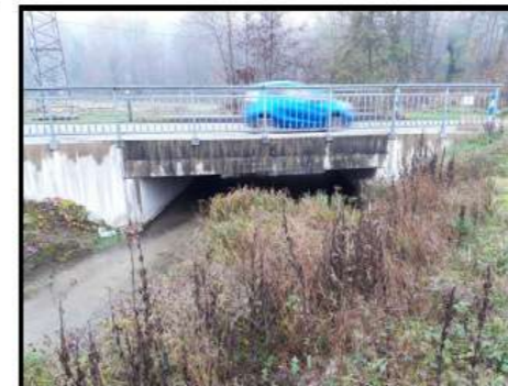
OH-06 - vue de l'amont
