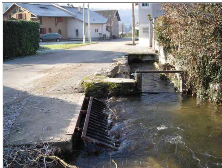
Le ruisseau de SAINT-SAVIN longe la voie communale rejoignant la RD143 et la VERCHÈRE. Des aménagements hydrauliques le contraignent et augmentent le risque de débordement. Plusieurs maisons sont menacées d'inondation.
