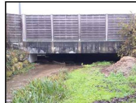
OH-07 - vue de l'amont
