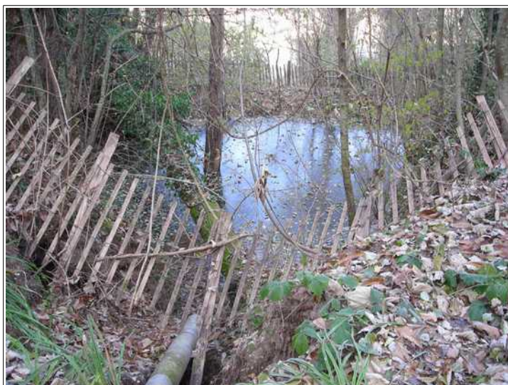
Petit bassin d'orage à l'aval de la combe du COIN, la nature argileuse du sol maintient l'ouvrage en eau (pas d'infiltration).
