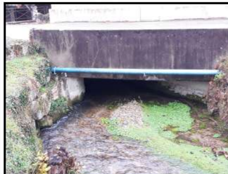
OH-04 - vue de l'amont
