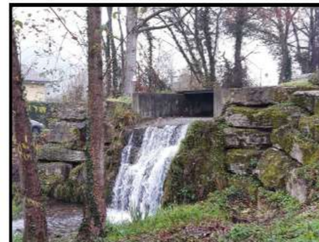
OH-05 - vue de l'aval
