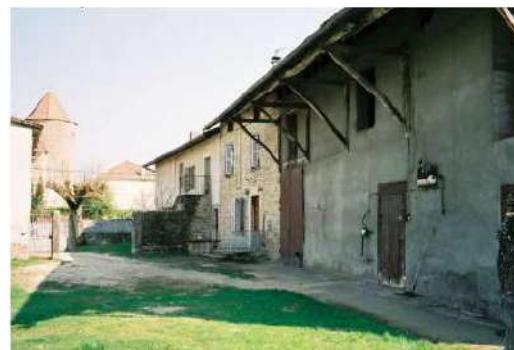
Les communs du château, ancienne propriété appelée « Courte »
