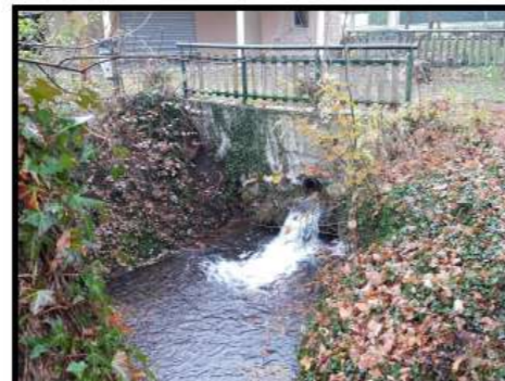
OH-11 - vue de l'aval
