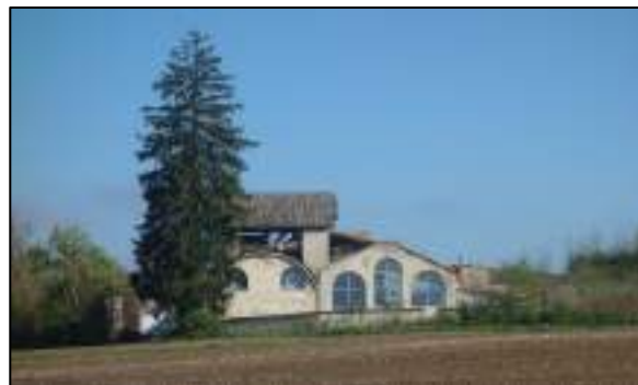
L'ancienne usine de chaux Chevrot-Deleuze :
