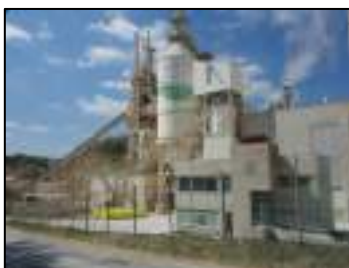
Usine à chaux de la société ECL
