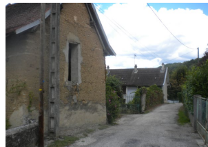
Toiture à coyaux
