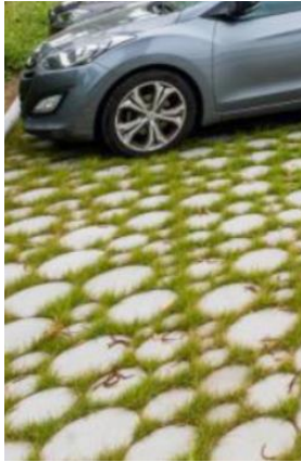
Pavés à joints élargis avec un remplissage végétalisé
