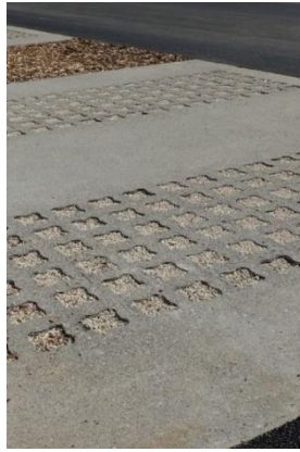
Pavés à joints élargis avec un remplissage gravillonné
