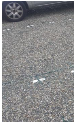
Les dalles alvéolées avec un remplissage gravillonné
