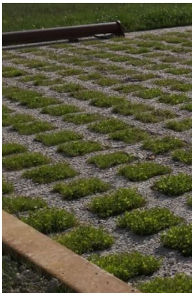
Béton alvéolaire avec un remplissage végétalisé
