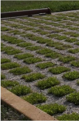
Béton alvéolaire avec un remplissage végétalisé
