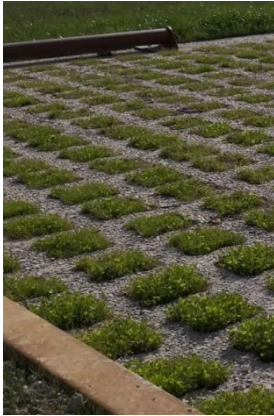
Béton alvéolaire avec un remplissage végétalisé
