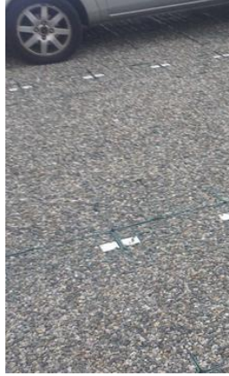
Les dalles alvéolées avec un remplissage gravillonné
