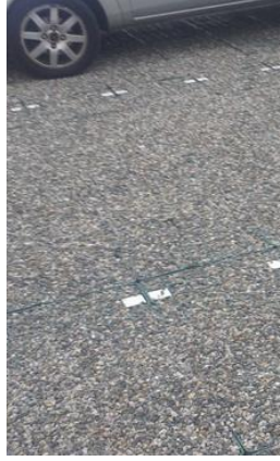
Les dalles alvéolées avec un remplissage gravillonné
