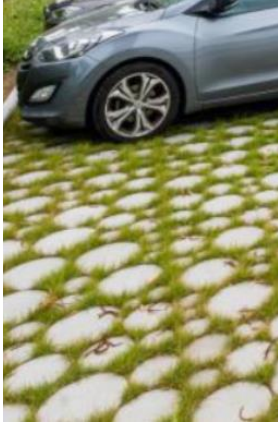
Pavés à joints élargis avec un remplissage végétalisé
