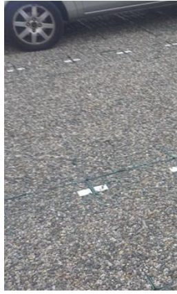
Les dalles alvéolées avec un remplissage gravillonné
