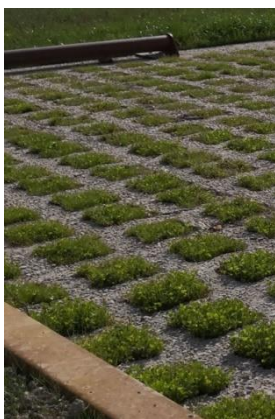
Béton alvéolaire avec un remplissage végétalisé
