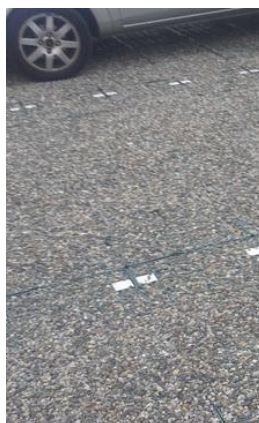
Les dalles alvéolées avec un remplissage gravillonné
