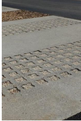
Béton alvéolaire avec un remplissage gravillonné
