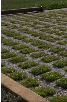
Béton alvéolaire avec un remplissage végétalisé
