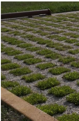
Béton alvéolaire avec un remplissage végétalisé
