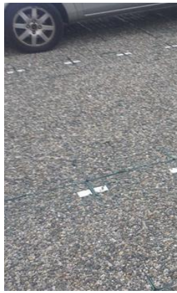
Les dalles alvéolées avec un remplissage gravillonné
