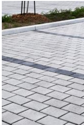
Les pavés drainants
