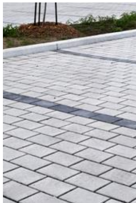
Les dalles alvéolées avec un remplissage gravillonné
