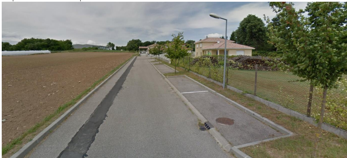
Voie en impasse avec stationnements latéraux, Chemin des Vergers
