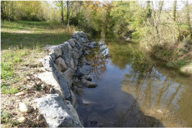
Photo : C. Lepargneur Enrochement important de la rivière (secteur Agnin) destiné à contenir, limiter les crues et débordements en cas de fortes pluies.
