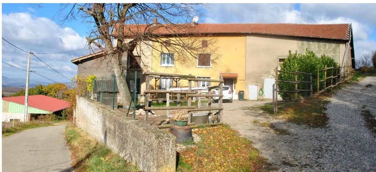
Bâtis anciens, volumes massifs et implanté à l'alignement de la voie
