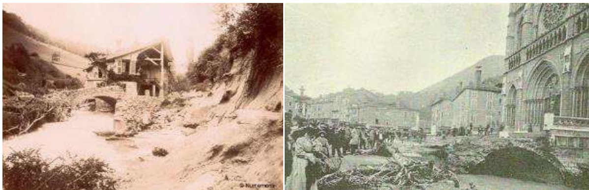
Inondations et dégâts provoqués par la crue de la Morge le 5 juin 1897 - Source : Diagnostic territorial de la Stratégie locale de Gestion du Risque Inondation Territoire à Risque Important d'inondation (TRI) de Grenoble – Voiron / Version 9 – février 2018
