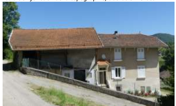
Implantation du bâti dans la pente, rue de Charpenousse -
