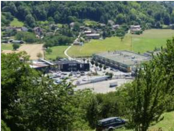
Vue dominante sur le val des Blanchisseries
