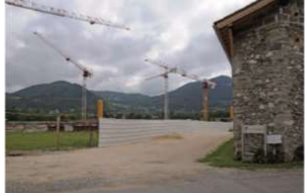
IMAGE 56 - NOUVEL HOPITAL depuis rue des Tallifardières, Voiron - 04/06/2018 ©Francis Helgorsky
