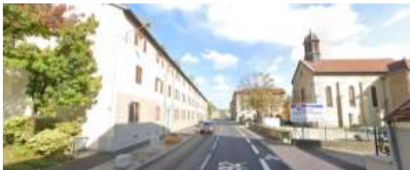
Traversée du groupement de Paviot
