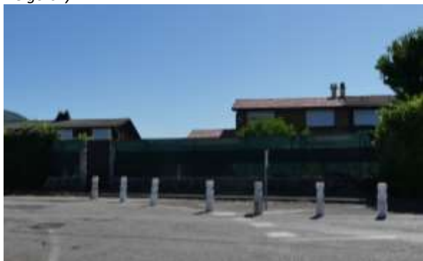
Espace pavillonnaire, clôture opaque et peu qualitative
