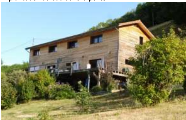
Implantation du bâti dans la pente, Le Grand Souillet
