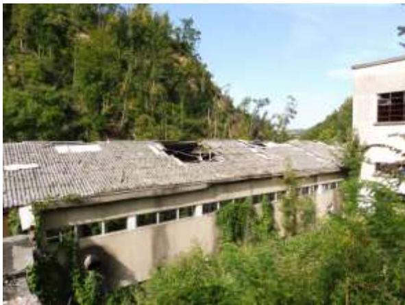
Anciens bâtiments industriels abandonnés
