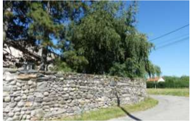
Mur de galets et pierres en limite de rue -Perception du parc arboré
