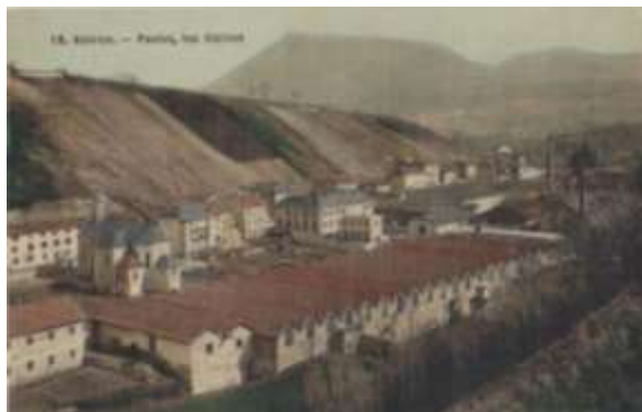
Usines quartier Paviot
