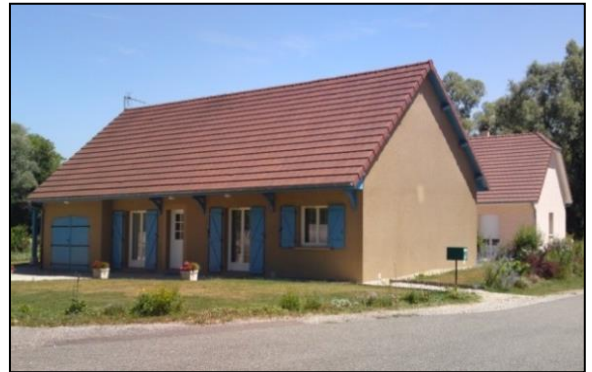
Les constructions sont généralement moins hautes que dans le centre ancien
