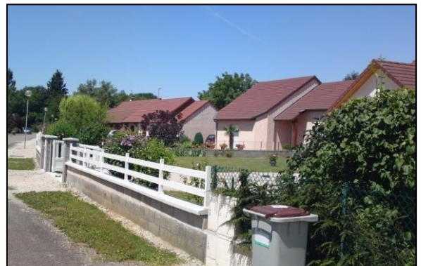
Ici, extension sous forme de lotissement
