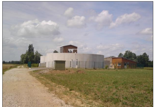
Station d'épuration de la commune située sur le territoire de NANCE
