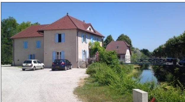
Logements locatifs récents
