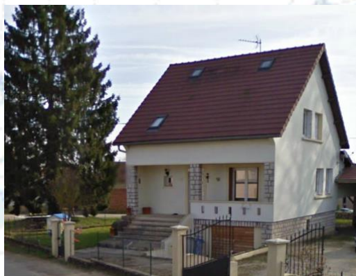
Construction intermédiaire sans rappel architectural à l'ancien typique des années 1970
