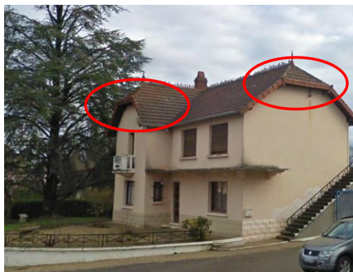
Construction intermédiaire avec toit en demi-croupe
