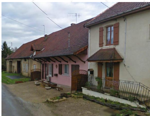
Constructions en limite séparative
