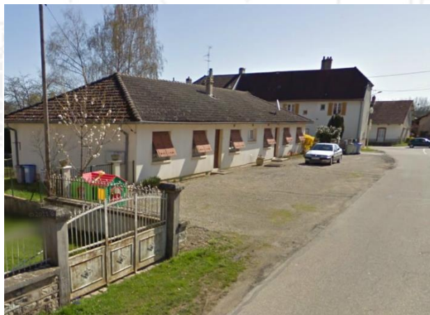
Maison installée au coup par coup
