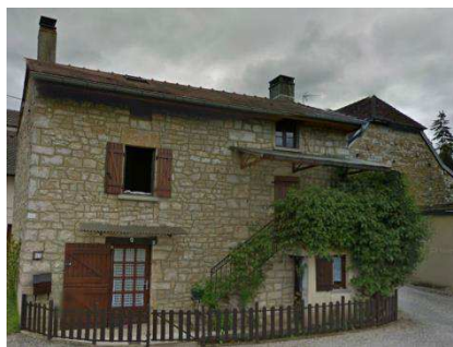
Constructions anciennes rue du Chapeau Rouge
