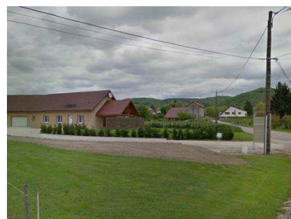
Constructions récentes route Champ de la Croix avec création d'une impasse privée
