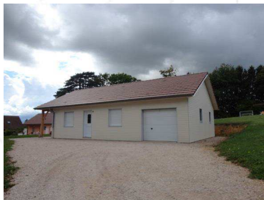
Construction neuve de petite taille dans un lotissement
