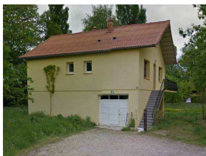
Construction intermédiaire implantée rue du Glacier
