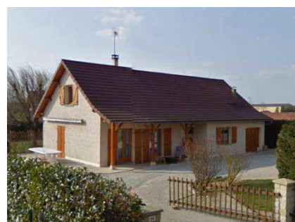
Construction intermédiaire rue de Boisdel
