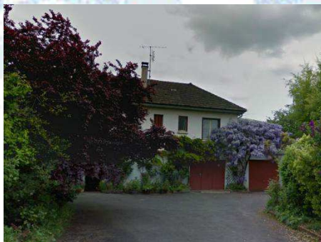
Construction intermédiaire implantée au coup par coup Route de Louhans
