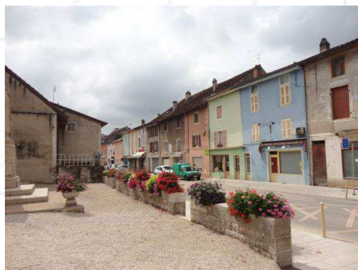
Constructions en limite séparative
