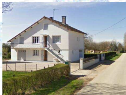
Construction intermédiaire implantée au coup par coup route de Fléria
